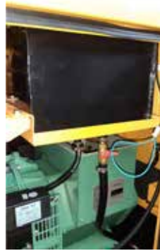
Tanque de Combustible Elevado.
